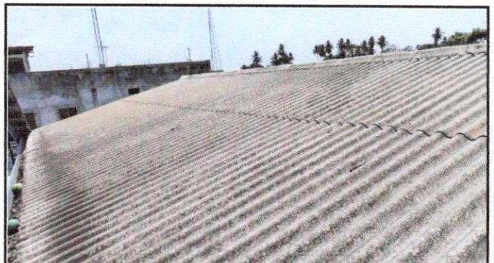
Foto 4: sustitución de duralita por lamina troquelada calibre 26 y mantenimiento de soporte de metal
