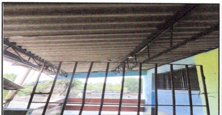
Foto 6: sustitución de duralita por lamina troquelada calibre 26 y mantenimiento de soporte de metal
